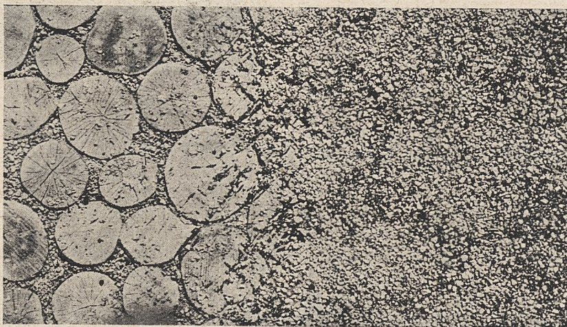
Nawierzchnia przysypywana tłucznem.
