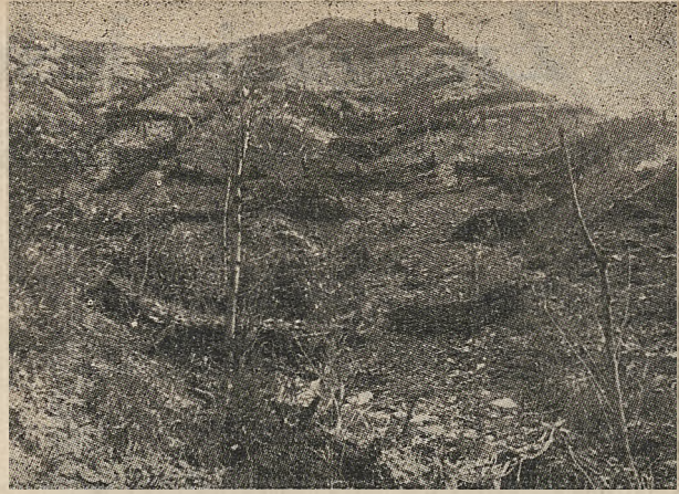
Usypisko w Sr. N. (Kąty). Ustalony płotkami wiklinowymi nieużytek i porosty trawą („Kępy”), wierzbą i olchą
