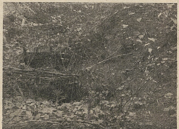
Ustalony żleb za pomocą zapór z wiklinowych, rosnących „płotków” i zalesiony olchą
