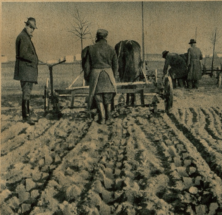
Maszyna do robienia dziur do sadzenia (zauważ powstawanie wzdłużnych dziur).
