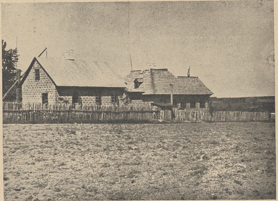
Budynek kąpieliska P. W. L. — W głębi „Dom strzelca i leśnika“
