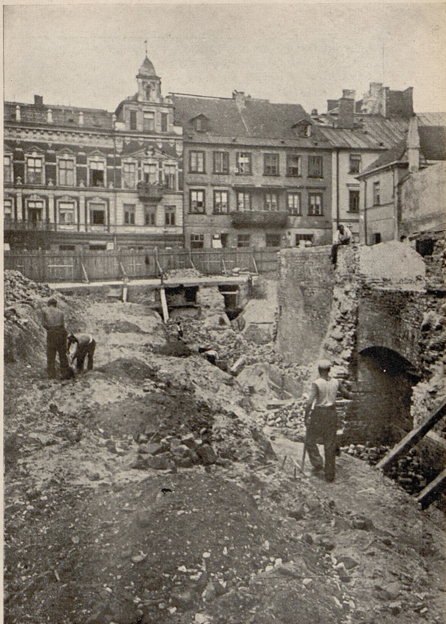
PRACE PRZY ODŚLANIANIU MURÓW MIEJSKICH.
