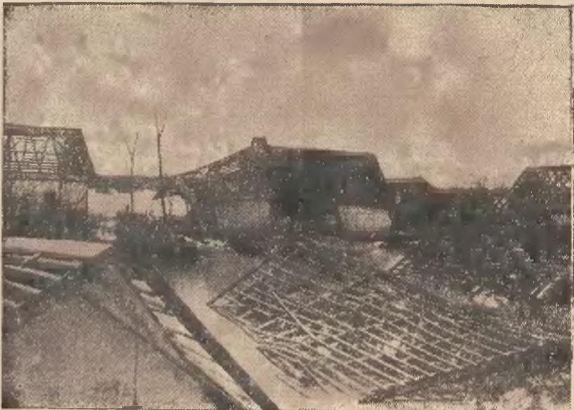
Zdjęcie nasze przedstawia zburzone domostwa w pobliżu Mako, które zostały zniszczone przez fale wezbranych rzek.
