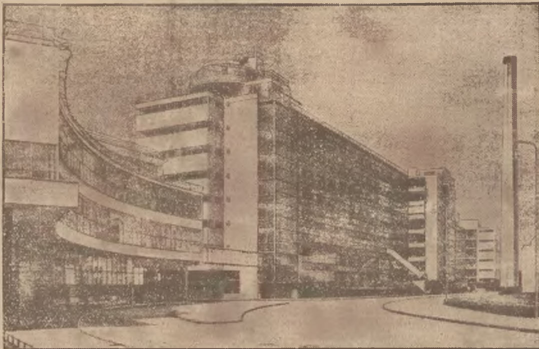
W Rotterdamie powstał gmach fabryczny, zbudowany całkowicie ze szkła i stali. Nowy ten rodzaj konstrukcji posiada wielkie znaczenie, dając duże i jasne ubikacje, które w nie-małym stopniu wpływają na stan zdrowotny zajętych tam pracowników.
